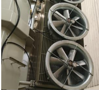
Gambar 2. 7 Cooling Fan
