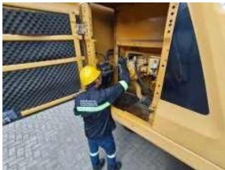
Gambar 4. 3 Memastikan Tidak ada Kebocoran
