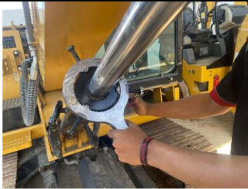
Gambar 3. 7 Pemasangan Alat Bantu ke Gland
