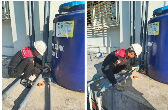
Gambar 3. 6 Pemasangan Sock Drat
