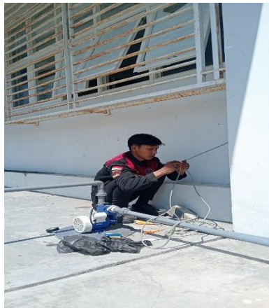
Gambar 3. 10 Penyambungan Kabel.
