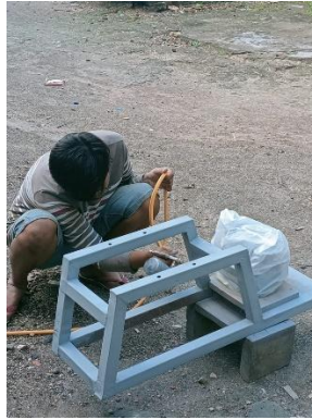
Gambar 4. 9 Proses Pengecatan Frame
